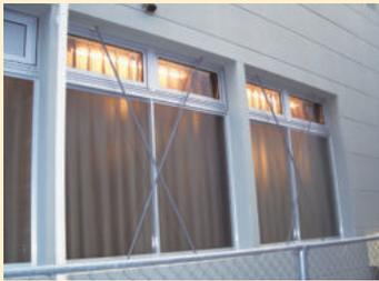
排煙窓の内倒しタイプで外ブレースの時に最適です。
