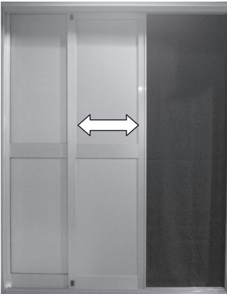
③障子吊り込み後、左右に可動確認して下さい。
