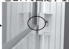
③写真円内がしっかりと下枠を固定しているか確認する。
